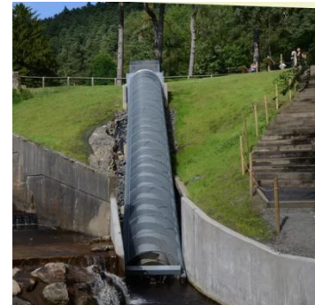
Figura 5-14 - Arquímedes tornillo
