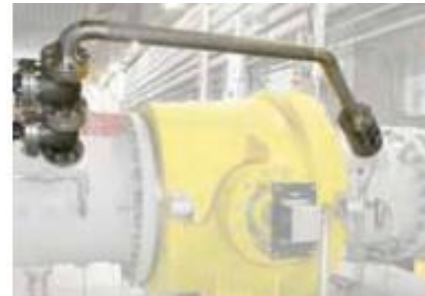
Figura 5-20 - La válvula de derivación
